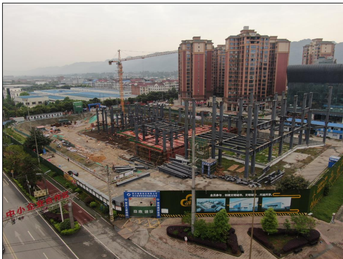
主体工程建设现状
