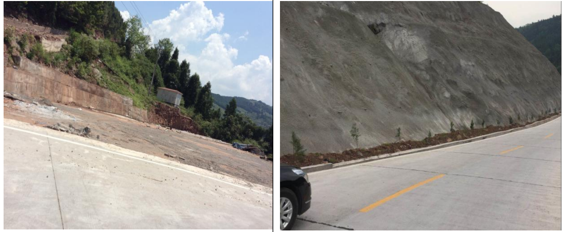
图 7-2 临时占地现状情况
